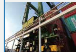
两港区场桥混合动力系统 全面投入使用
